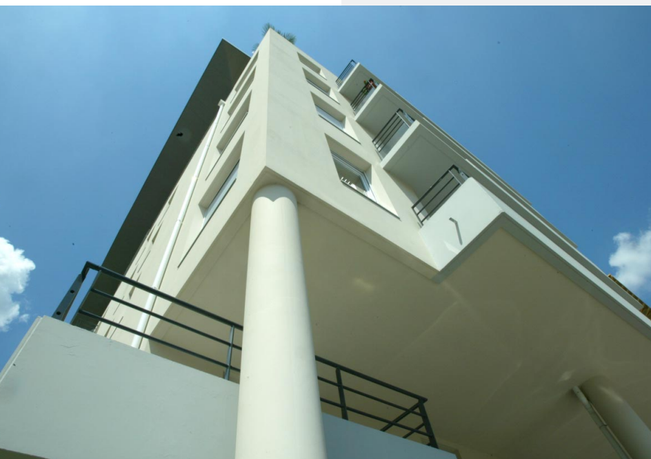
Budynek Euro Plaza
